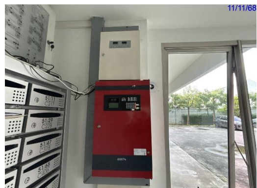
ภาพที่ 2.2-6 ระบบป้องกันและเตือนอัคคีภัย
